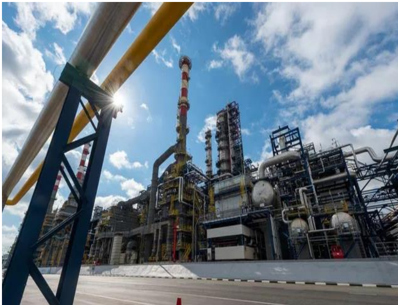
Разведке месторождений нефти
